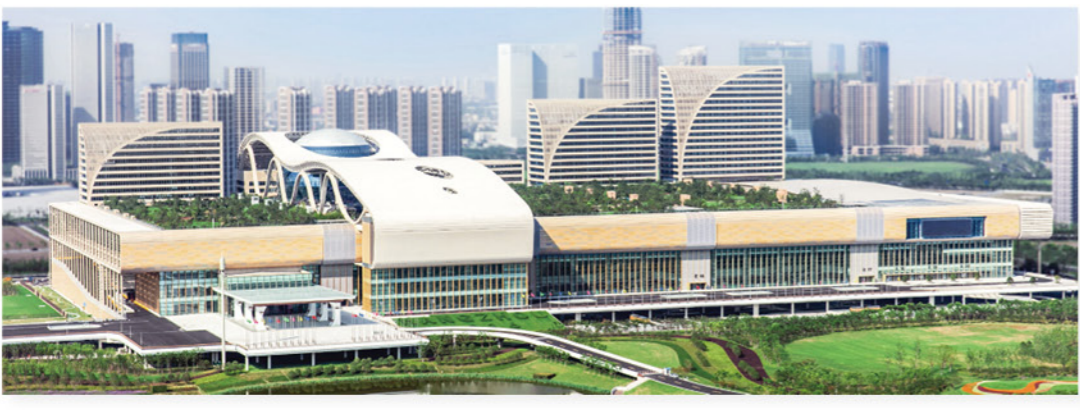
杭州国际博览中心 (安装参建) (鲁班奖, 国家优质工程金质奖, 詹天佑奖)
