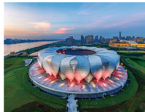
杭州奥体中心主体育场 (安装参建) (鲁班奖)
