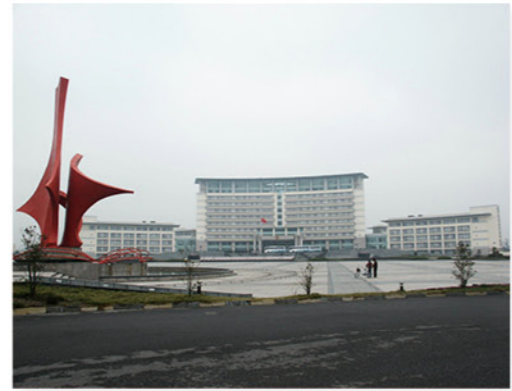
嘉兴市行政中心综合楼 (安装参建) (鲁班奖)
