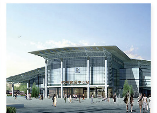
杭州客运中心站一期 (安装参建) (鲁班奖)
