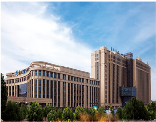
浙江省老年医院医疗中心项目 (安装参建) (中国安装之星)
