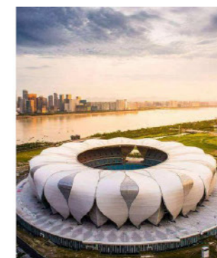
杭州奥体中心-鲁班奖
